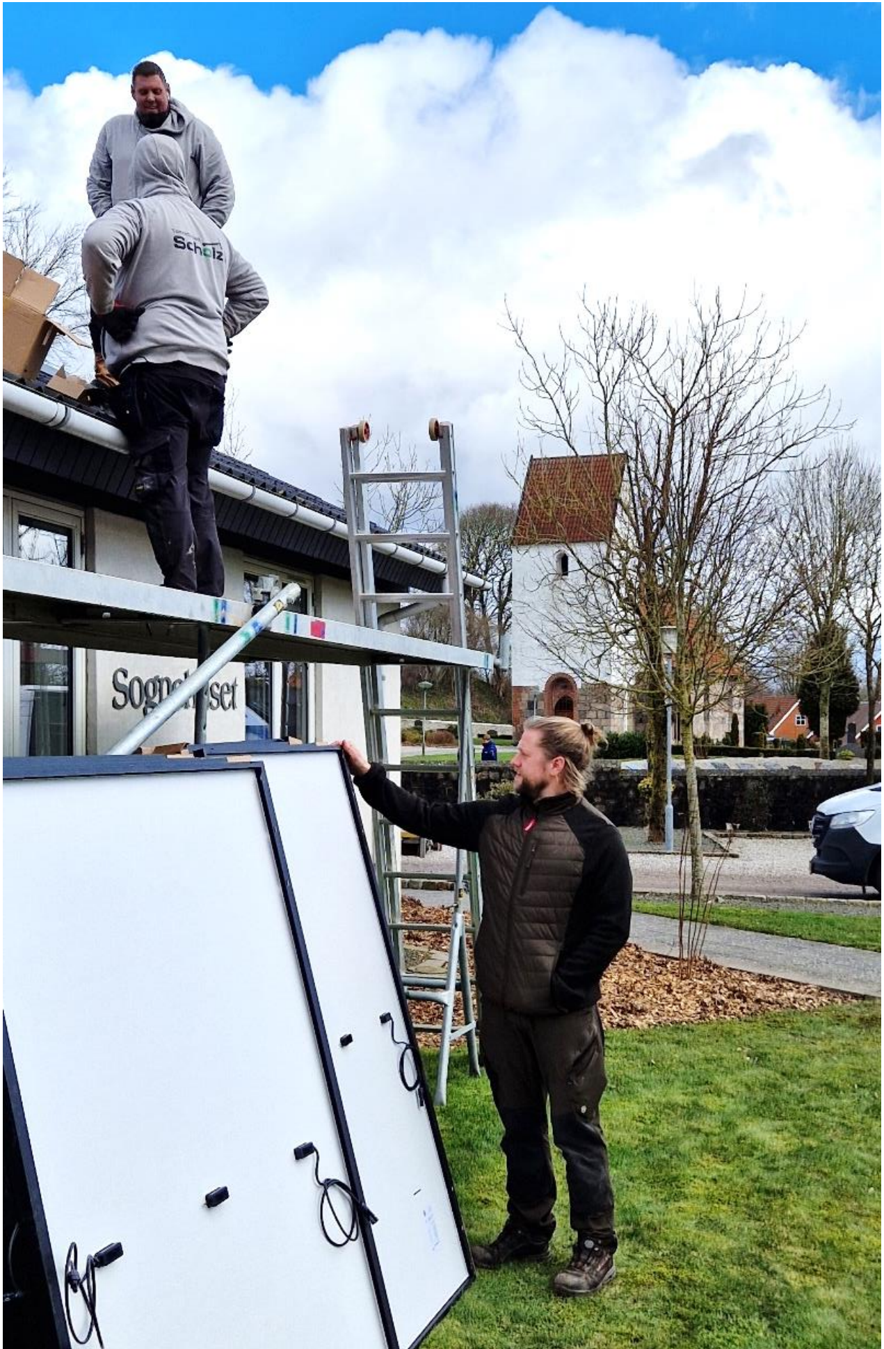
Solceller sættes op på Sognehuset
