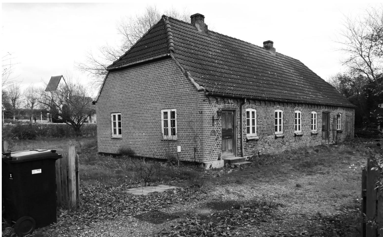
Stationsvej 1, som stadig venter på kommunens byggetilladelse.
