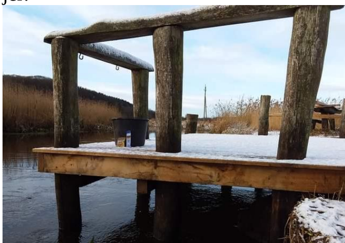
Renoveret anløbsbro ved Nørreåen
