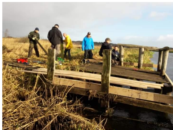
Arbejde på anløbspladsen ved Nørreå.
