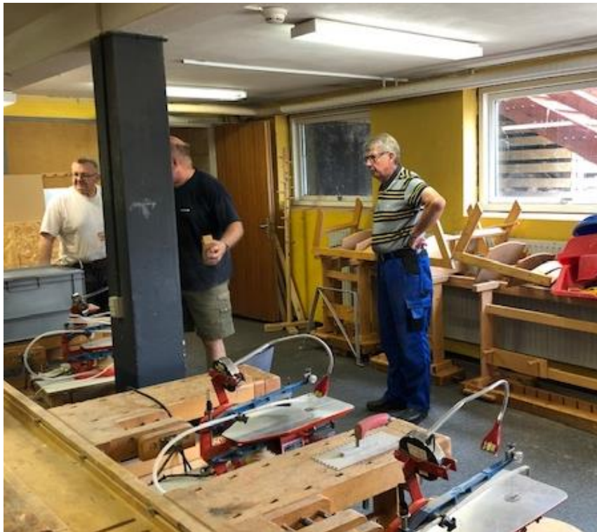
Renovering af lokale forberedes
