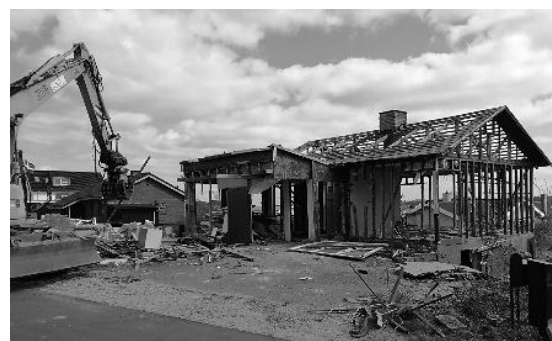
Nedbrydning af vaskehuset og Almindhuset
