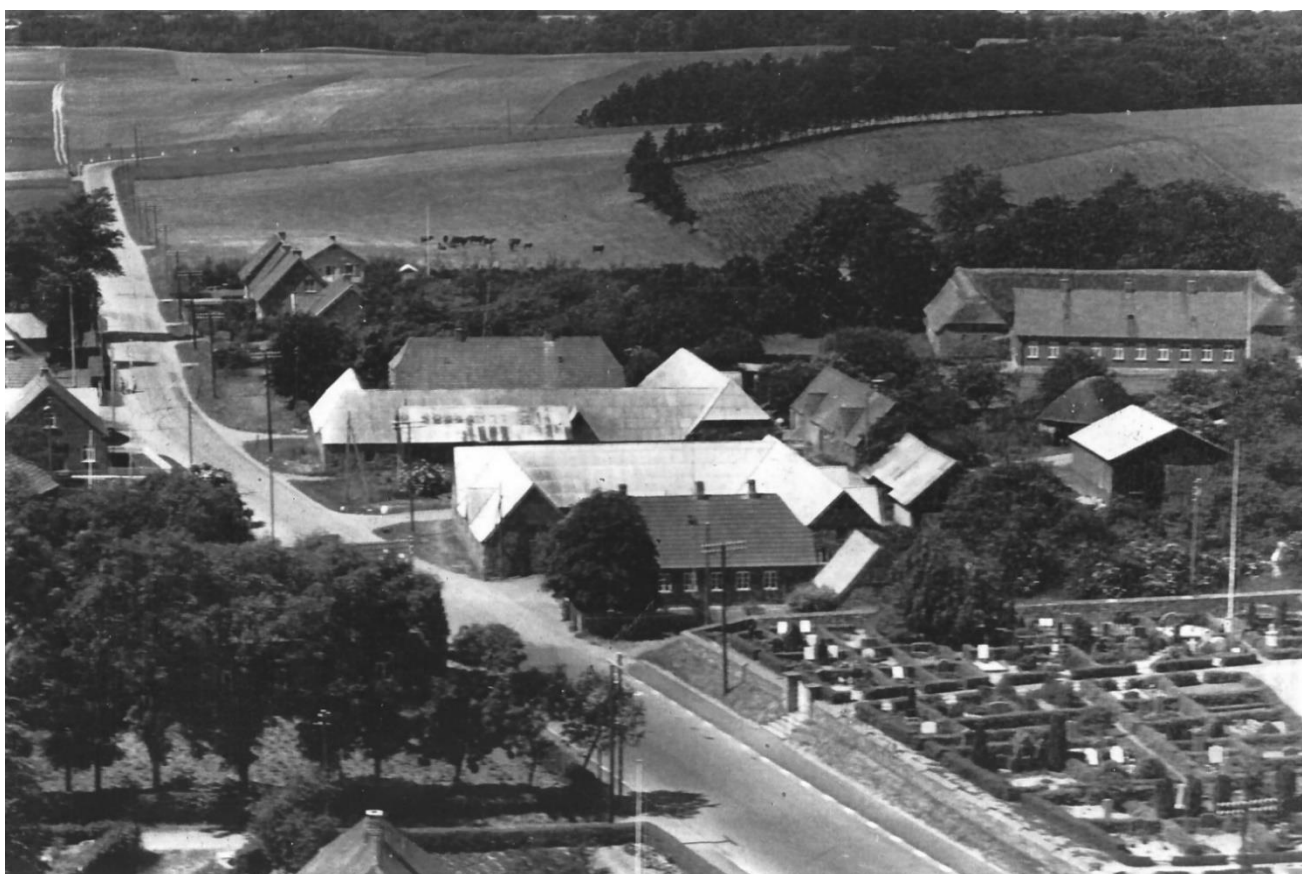
På billedet ses de nu nedrevne gårde, Tapdrupvej 81 og 83.
