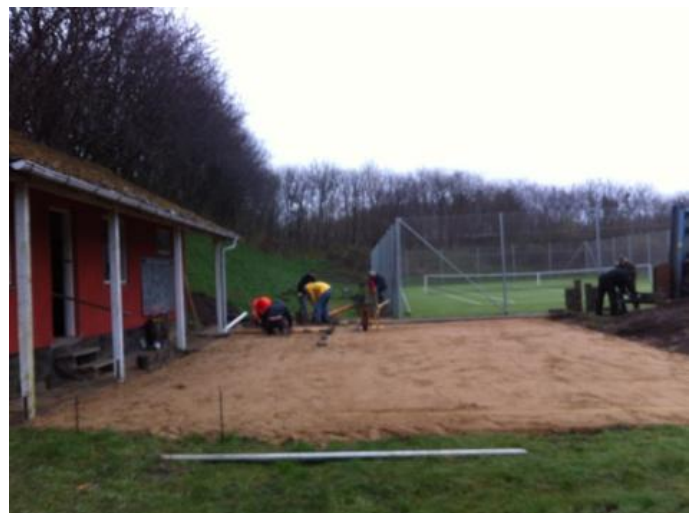
Der arbejdes med flisebelægning
