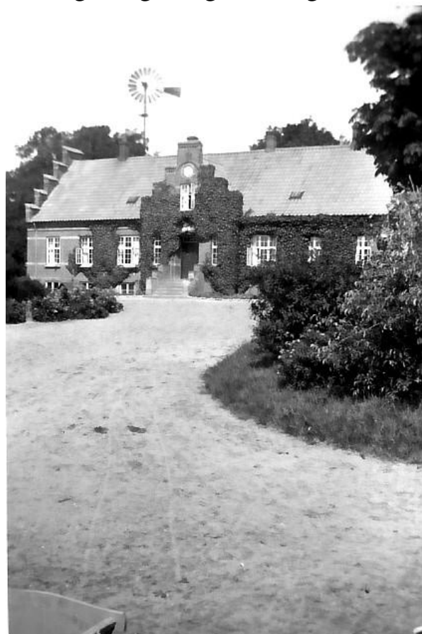
Indkørsel til Skovsgårds hovedtrappe. I baggrunden ses vindmøllen til vandforsyningen.
